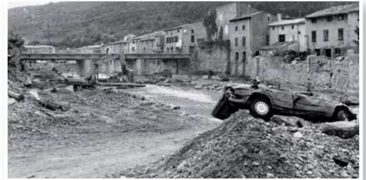
Inondation de septembre 1992, source Mairie de Couiza
