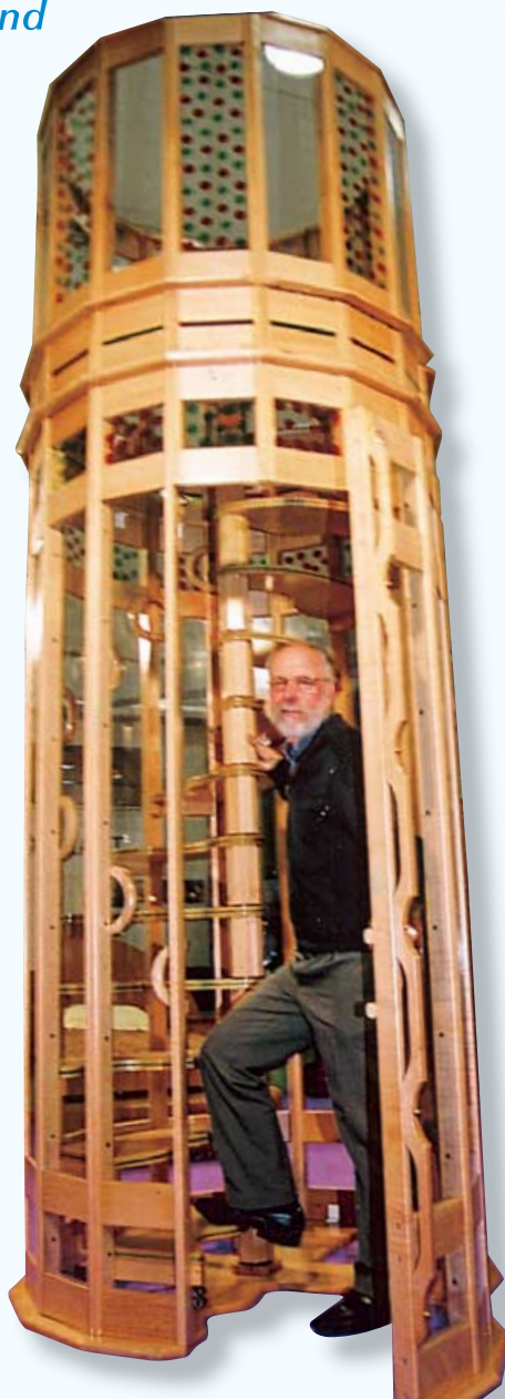
Toutes les marches sont montées sur des roulements à aiguilles. Ainsi, les marches peuvent pivoter à 360°.
