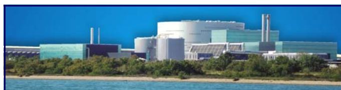
EveRé : 1 er centre multifilière de traitement des déchets ménagers en France
